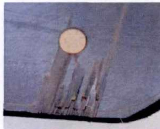
层间开裂损伤
